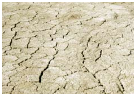
Leran spricker när den blir torr ...
