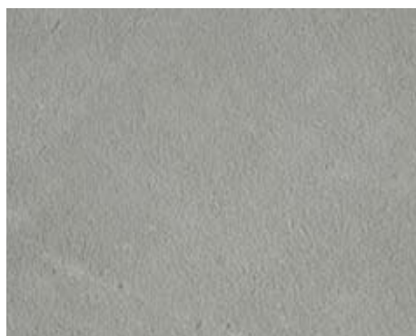
Perfekt gjuten och behandlad betongyta.
